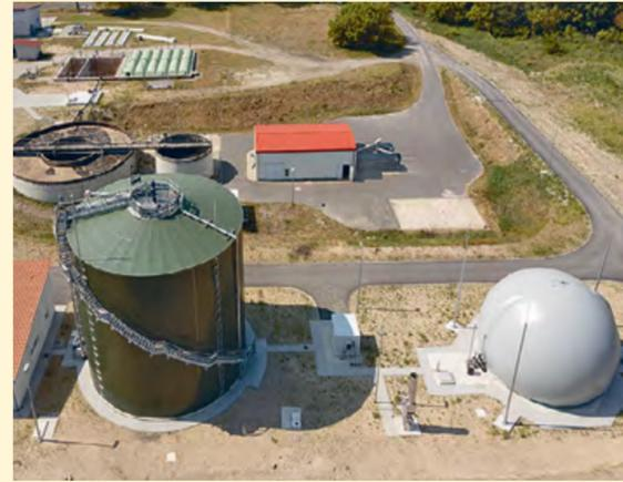
Beim Abwasser stand neben der Neuerschließung vieler Orte im Verbandsgebiet die ständige Erweiterung der Tandemkläranlage Zossen-Wünsdorf im Fokus. So gingen 2021 Faultrum und Gasbehälter in Betrieb.
