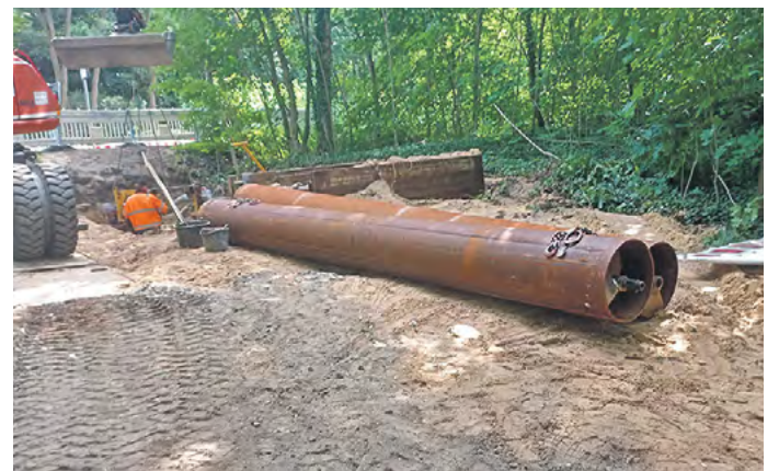
Mantelschutzrohre mit extra dicker Wandung bohren die Abwasserdruckleitung durchs Erdreich.
