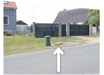
Unter diesem Schachtdeckel zieht moderne, druckregulierende Technik ein.
