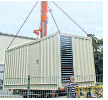
Anfang Juni setzte ein Kran das Aggregat an seinen geplanten Platz.
