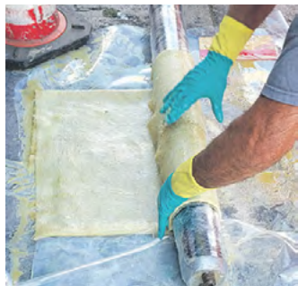
Der so vorbereitete Inliner wird um einen aufblasbaren sogenannten Packer gewickelt und zur ermittelten Schadstelle transportiert.
