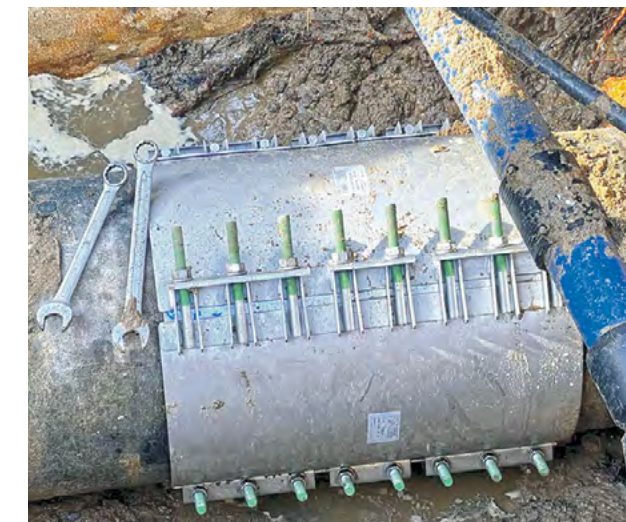
Am selben Tag war die neue Schelle montiert und dichtete die Leitung wieder ab.
